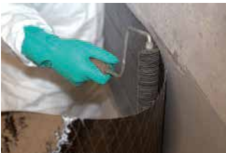
Aplicación de manto con rodillo laminador
